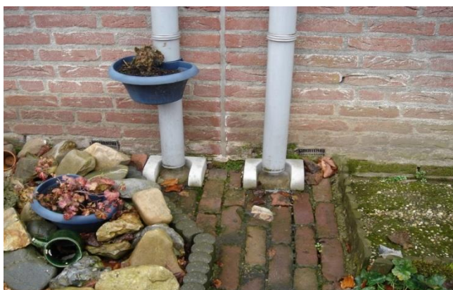
Figuur 6-6: Afkoppelen van hemelwater
