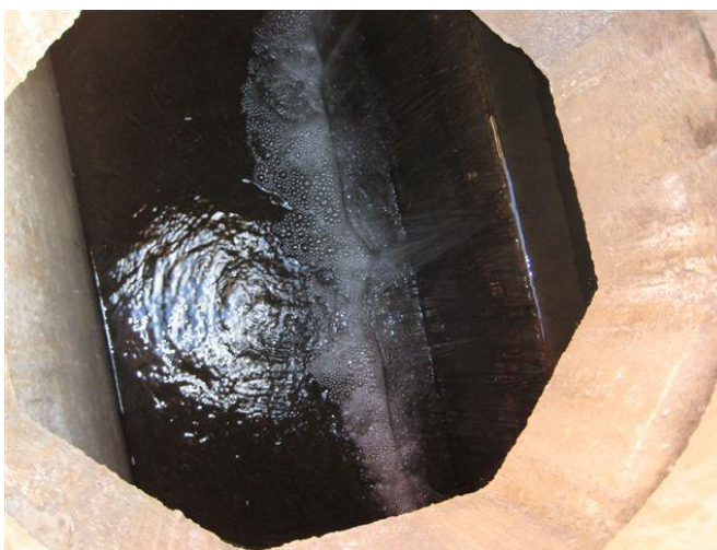
Figuur 3-4: Overstort in werking
