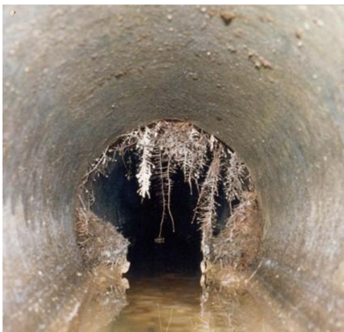
Figuur 5-3: Wortelingroei in rioleringsbuis
