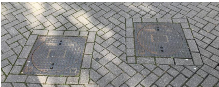
Figuur 6-4: Gescheiden riolering - vuilwater en schoon water
