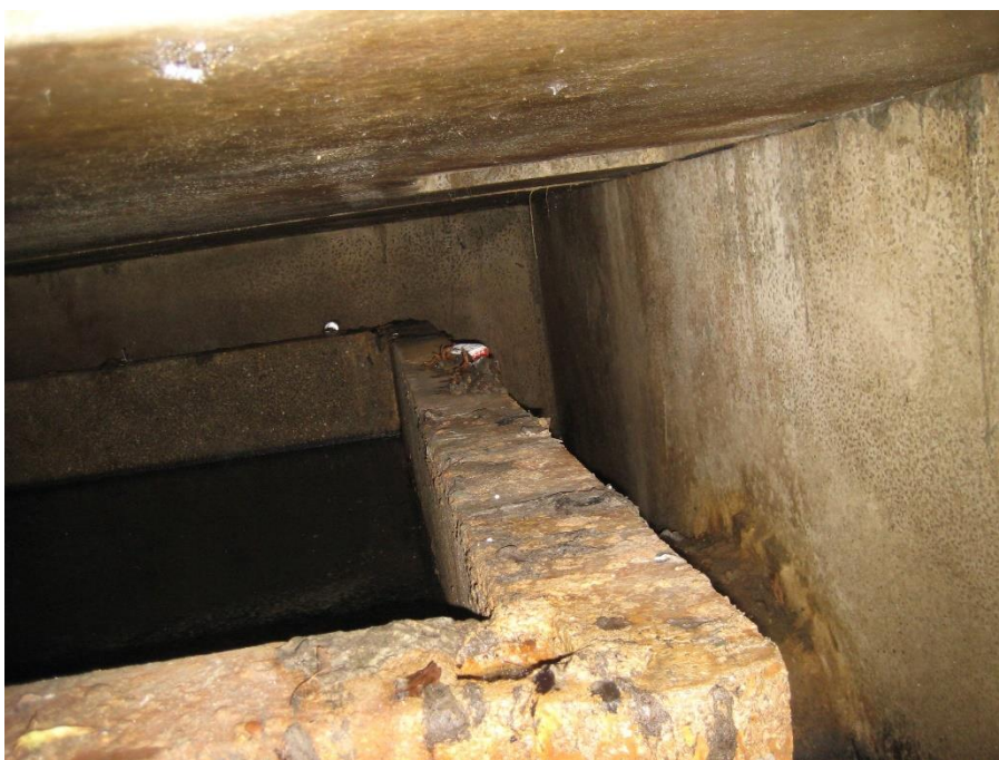
Figuur 6-2: Overstortmuur in put
