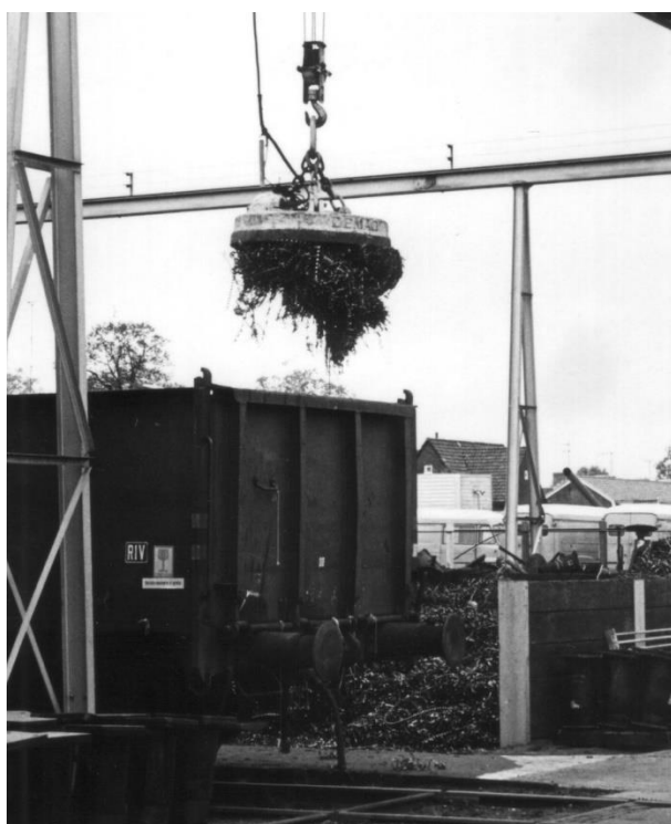
Werken met een schrootmagneet. (Foto onb.) Doorsnede hefmagneet. (Uit Thierens)
