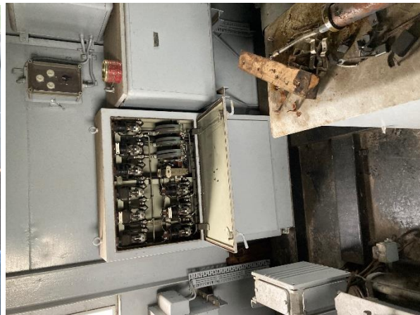
Bedieningskast en gelijkrichter voor de hefmagneet (Foto: Hens ter Kuile)
