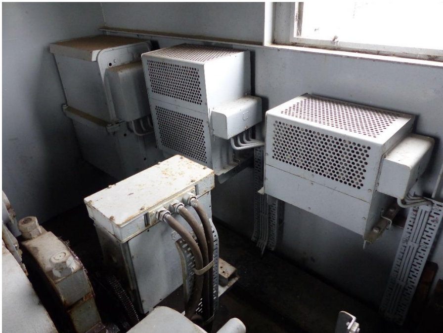
Weerstandskasten en spileindschakelaar (Foto: Helmig Kleerebezem)
