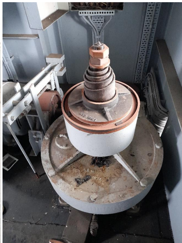
Detail slipkoppeling (Foto: Helmig Kleerebezem)
