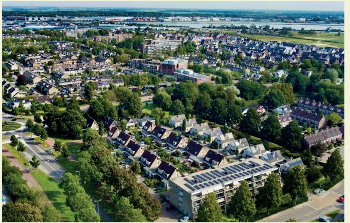
Maar liefst 194 zonnepanelen liggen er op het dak van appartementencomplex De Boetzelaer.
