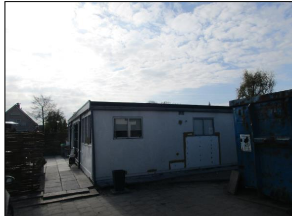
Foto 4: Tijdelijke woning in plangebied
