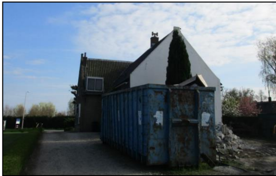
Foto 5: Hoofgebouw, zuidelijk in plangebied
