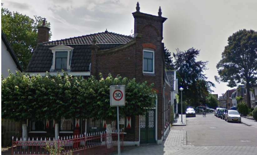
Afbeelding 3: Straatbeeld bestaande situatie
