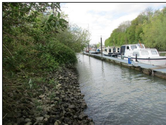
Foto 8: Noordoever bestaande uit basalt
